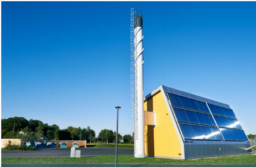
Figur 4 Panncentral med solfångare Vallda Heberg, Kungsbacka
